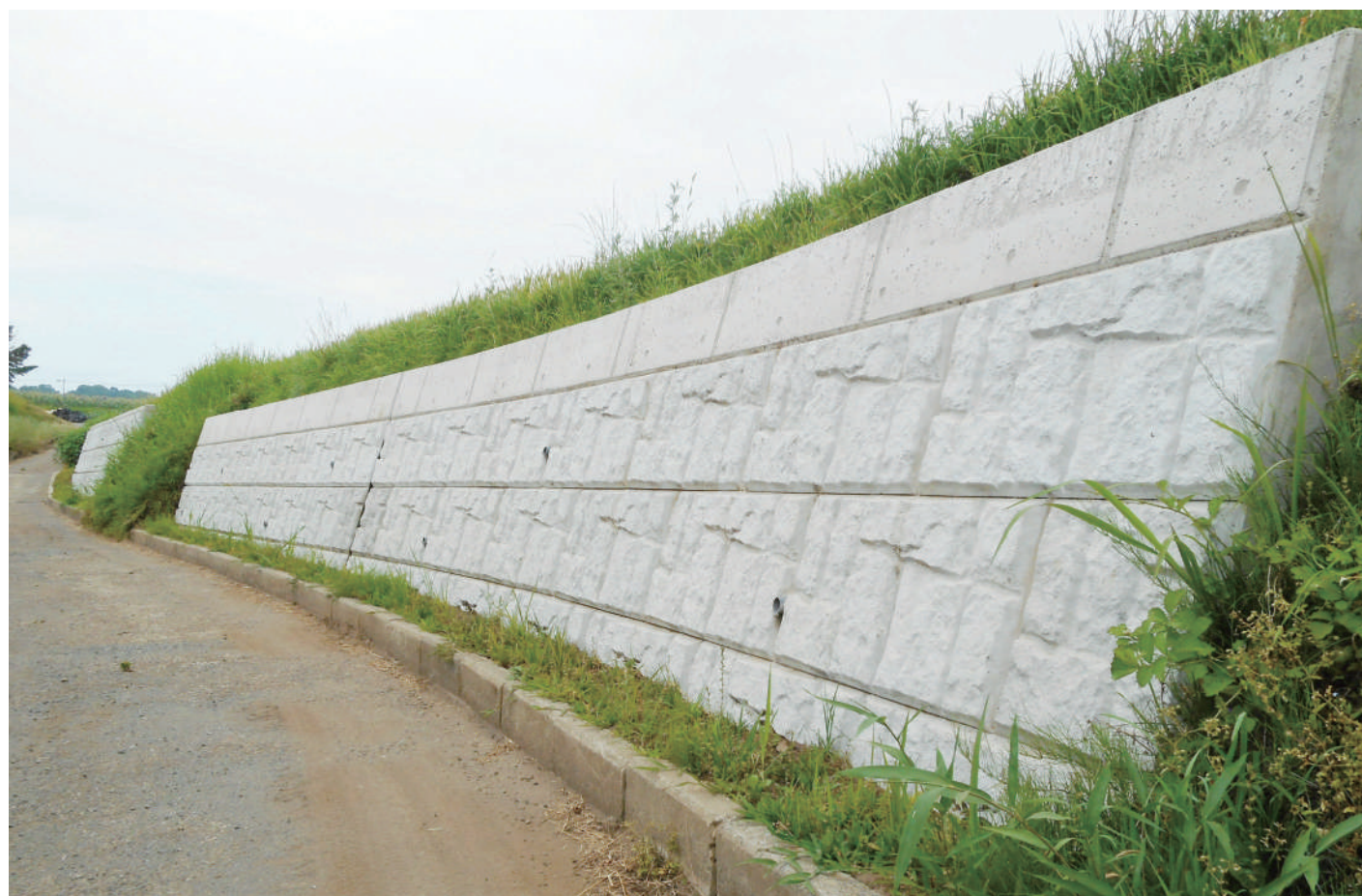
法面補強工事で活躍する中型ブロック施工例。法面の規模や形状にも柔軟に対応できる使い勝手の良さから、様々な現場で使われている。
