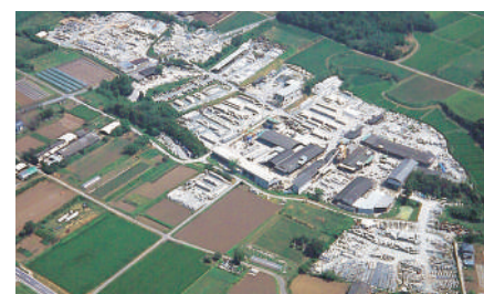
実に2500種類に及ぶコンクリート2次製品を生産する熊本不二コンクリート工業本社工場全景
