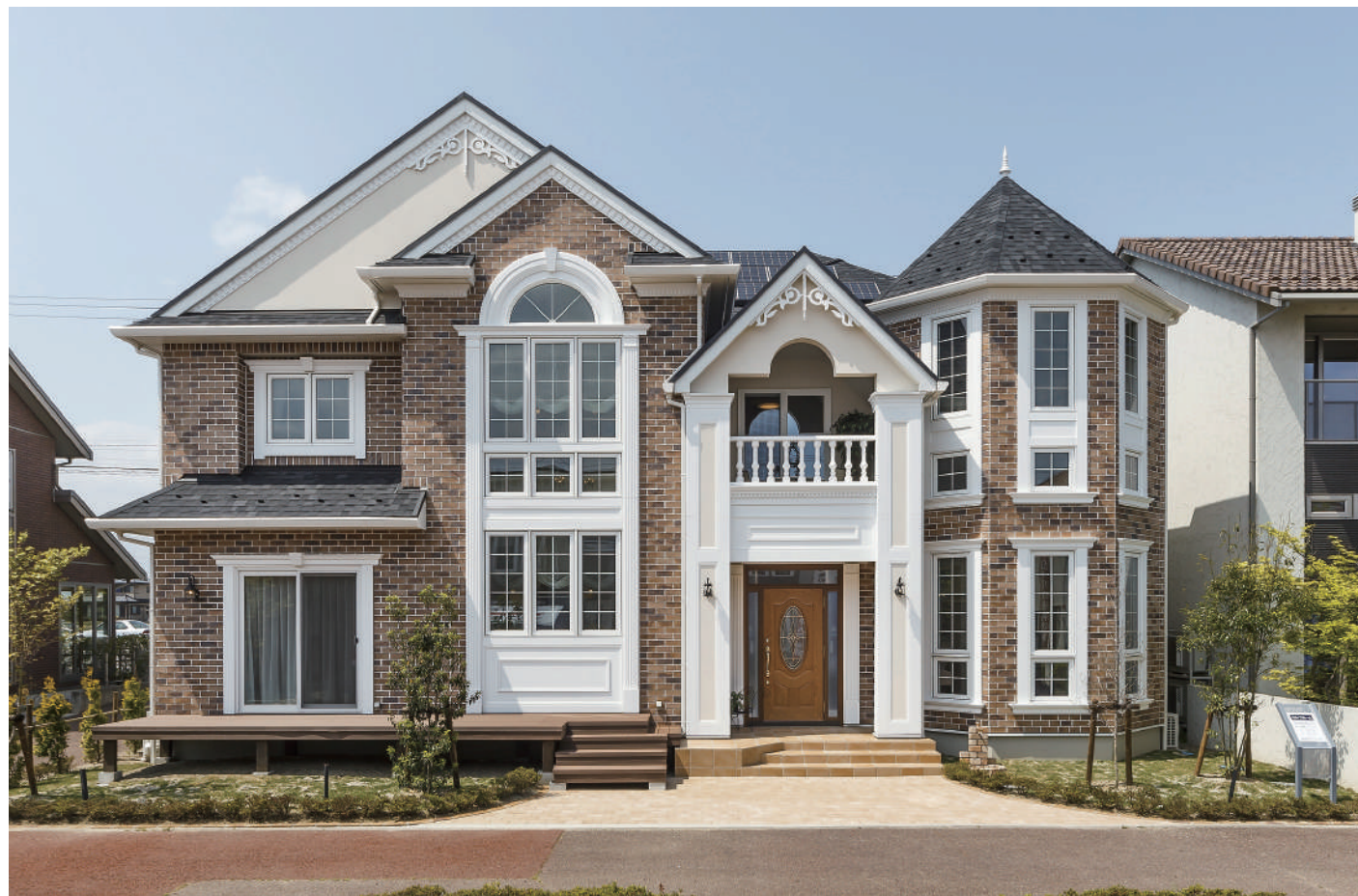
カナディアン輸入住宅「セルコホーム」施工例
