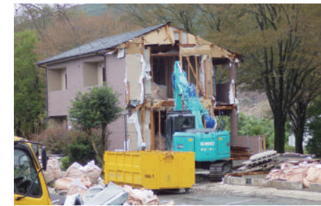
熊本市内の一般家屋解体工事現場。熊本地震による県内の住宅被害はトータルで約19万棟に上っている
