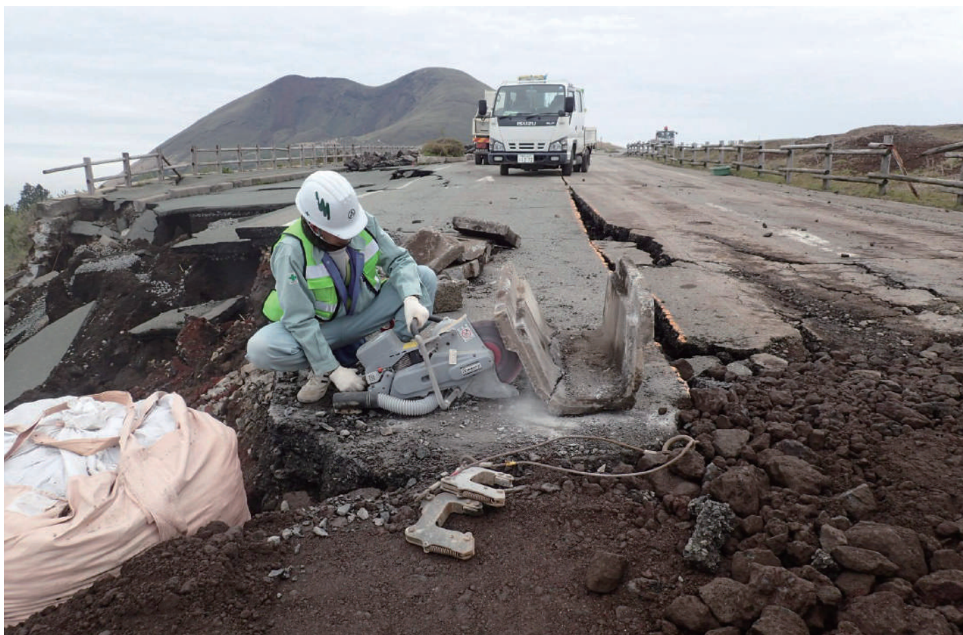
被災道路の応急復旧に取り組む建設業協会会員
