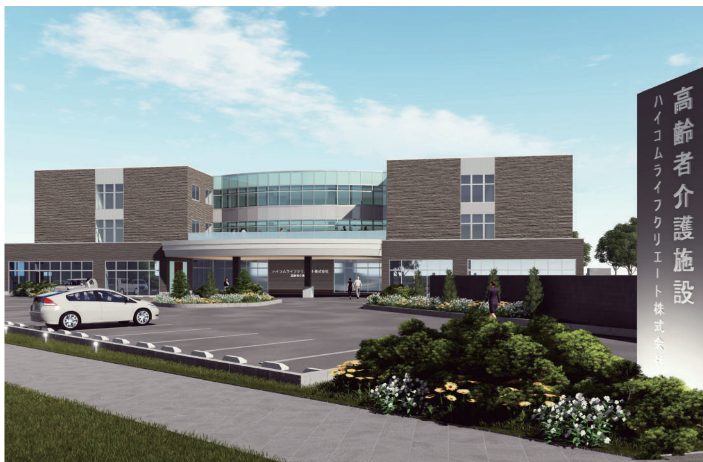
熊本市北区楠8丁目に開設予定の高齢者福祉施設。2、3階が住宅型有料老人ホームとなる
