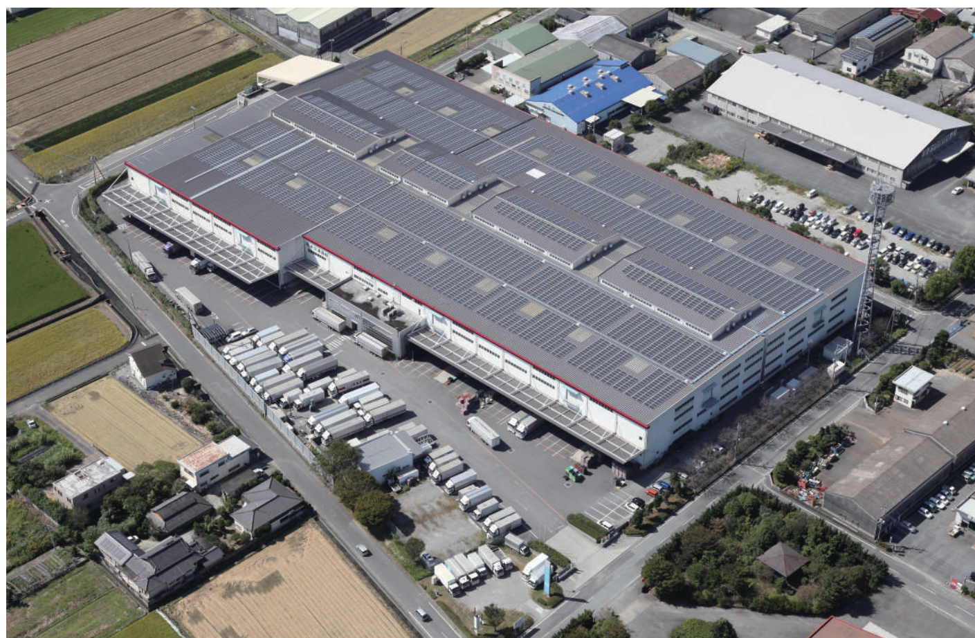
太陽電池パネルを設置した鏡事業所物流倉庫
