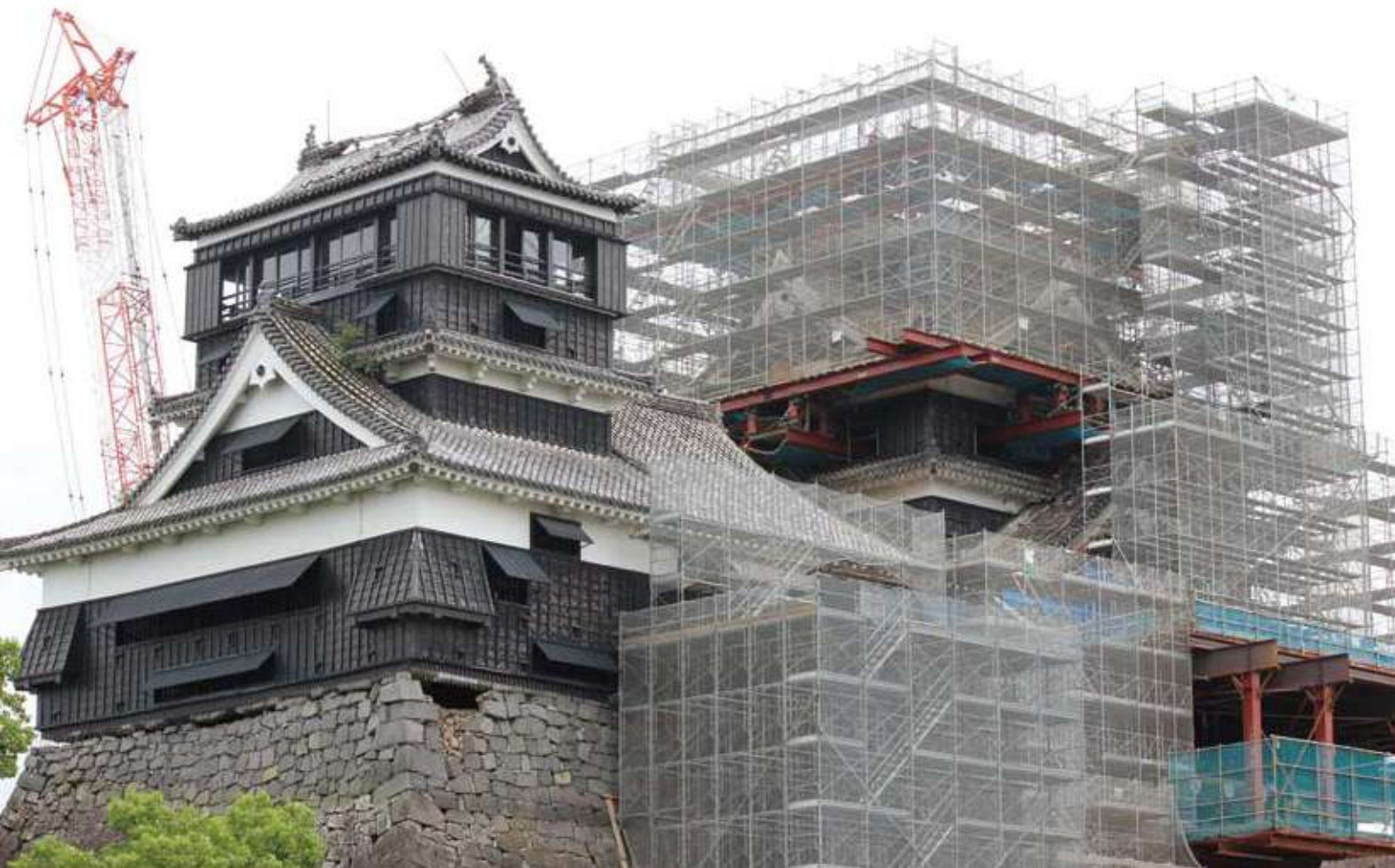
2019年までの復旧を目指し工事が進む熊本城大天守
